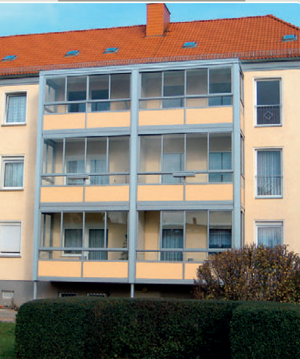
Anbau von 6 verglasten Balkonen (Siehe Seite 10)
