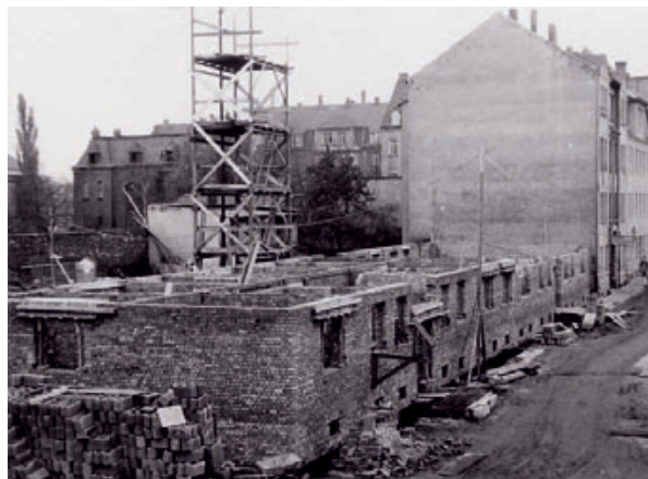
„Aylsdorfer Straße 18 – die erste Etage wird hochgezogen“
