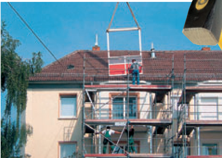
■ Montage der vorgefertigten Balkonelemente durch die Firma Kirsch
