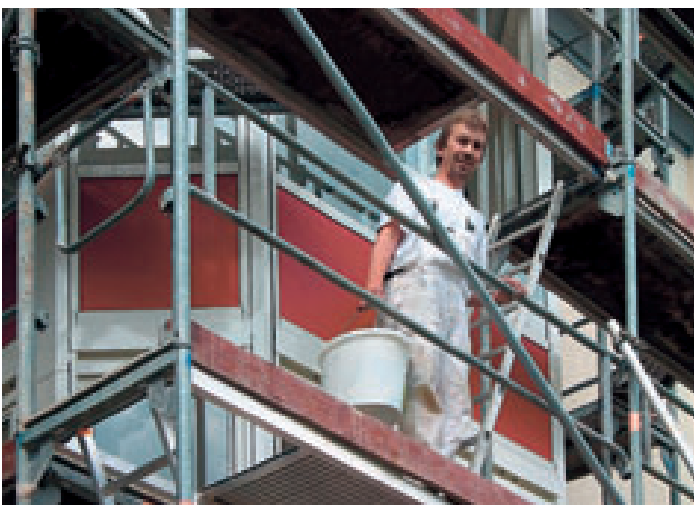
■ malermäßige Ausbesserungsarbeiten durch die Firma Rommel
