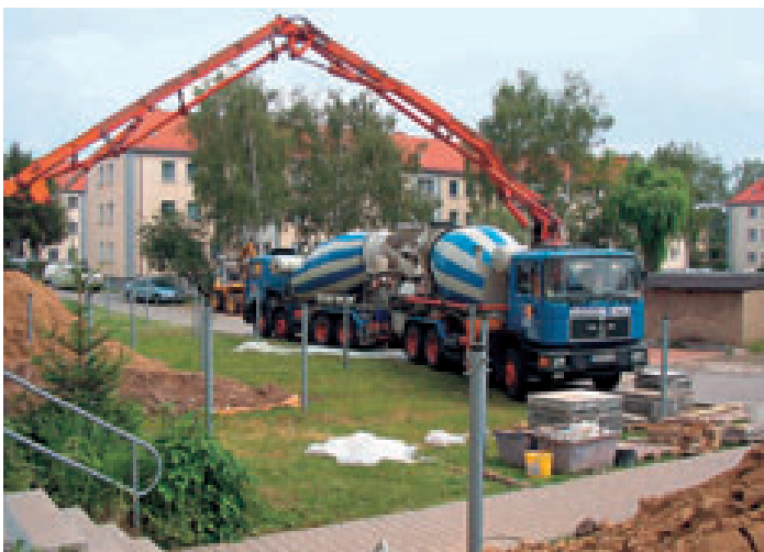
■ Herstellen der Fundamente für die Balkonkonstruktion durch die Hochbau- und Handelsgesellschaft Kayna mbH
