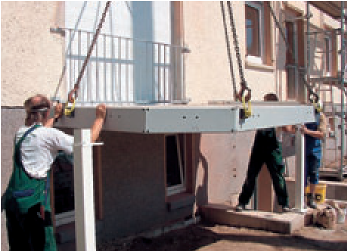
■ Aufstellen der Balkonkonstruktion durch die Firma Kirsch
