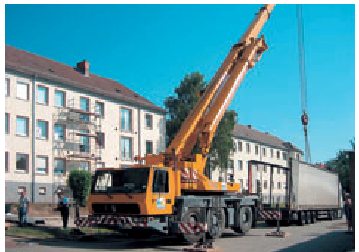
■ Anlieferung der Balkonkonstruktion durch das schwedische Unternehmen „Balco“
