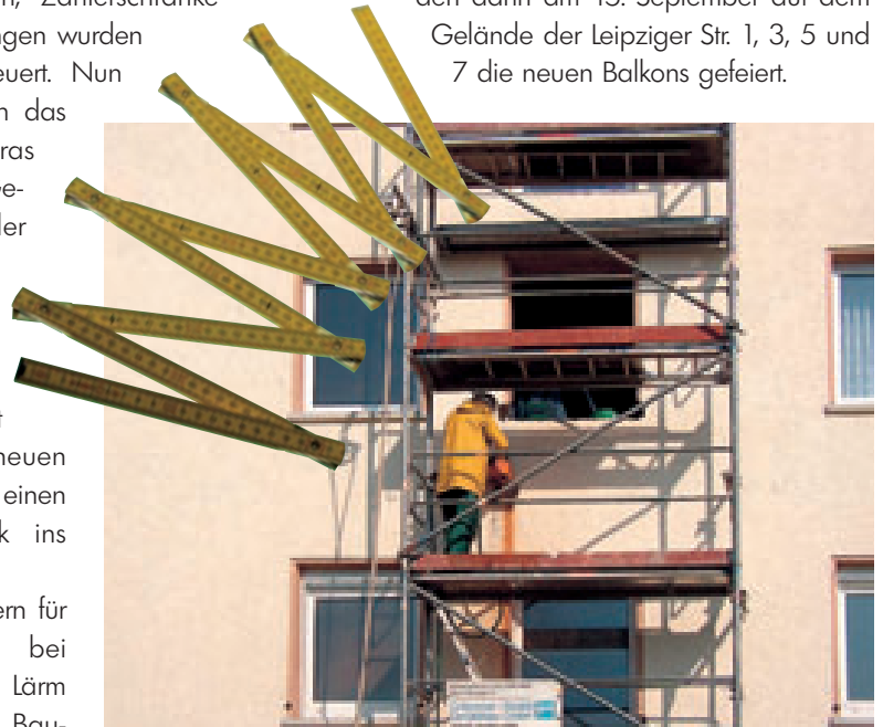
■ Einschneiden der Balkontüren mit einer Kettensäge durch die Kunststoff- und Metallbau Dietmar Kirsch GmbH
