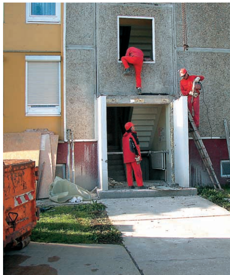
erste Abbrucharbeiten für den Aufzug
